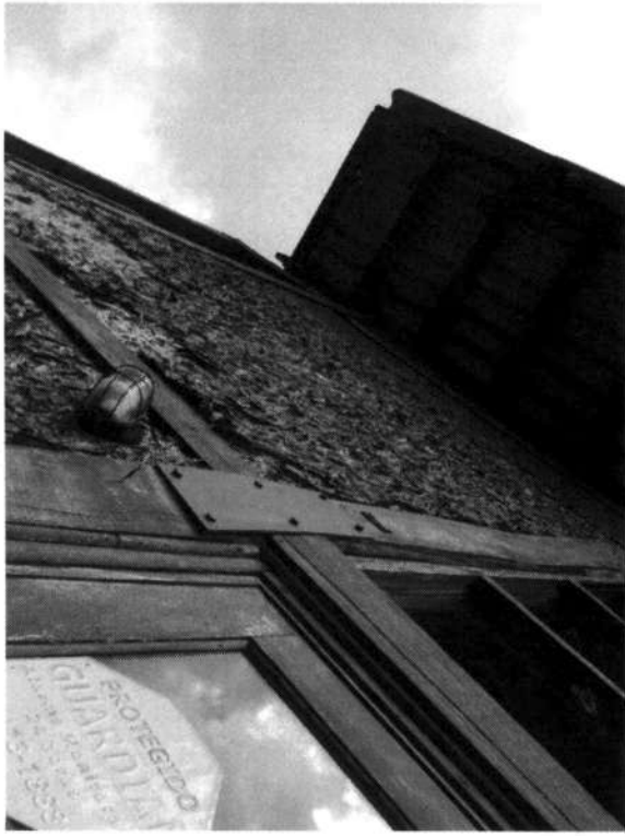
Foto 5 e 6 – Face Oeste superior e Quadro de luz interno
