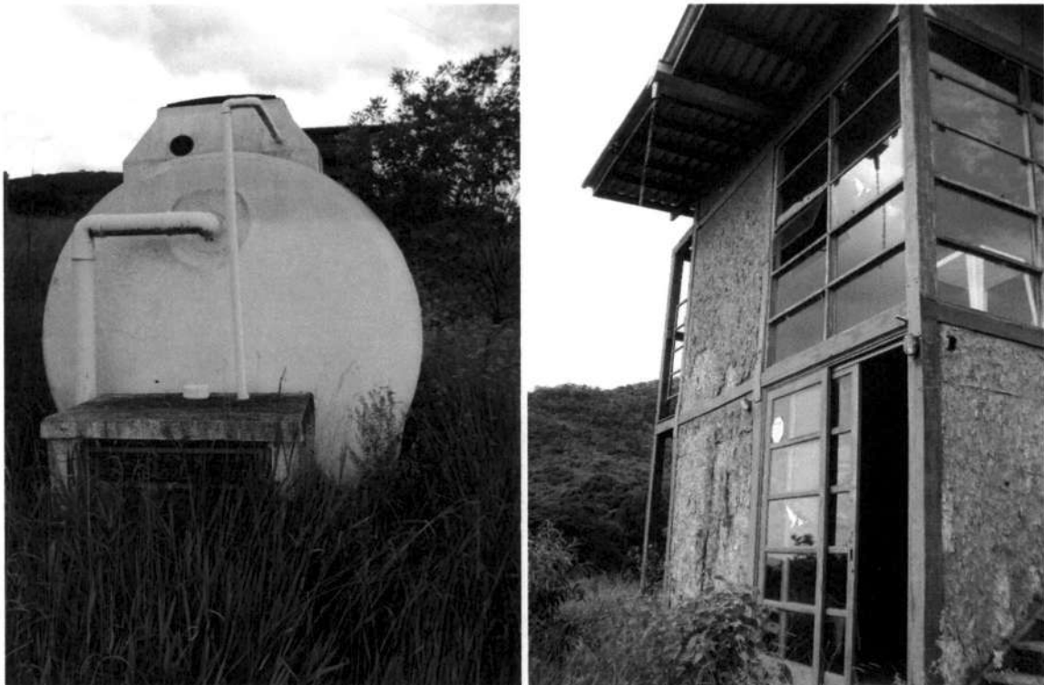
Foto 20 e 21 – Biodigestor e Face Oeste
