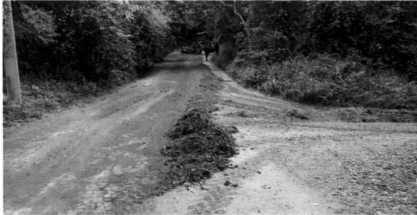
Foto 1 Manutenção na Estrada
