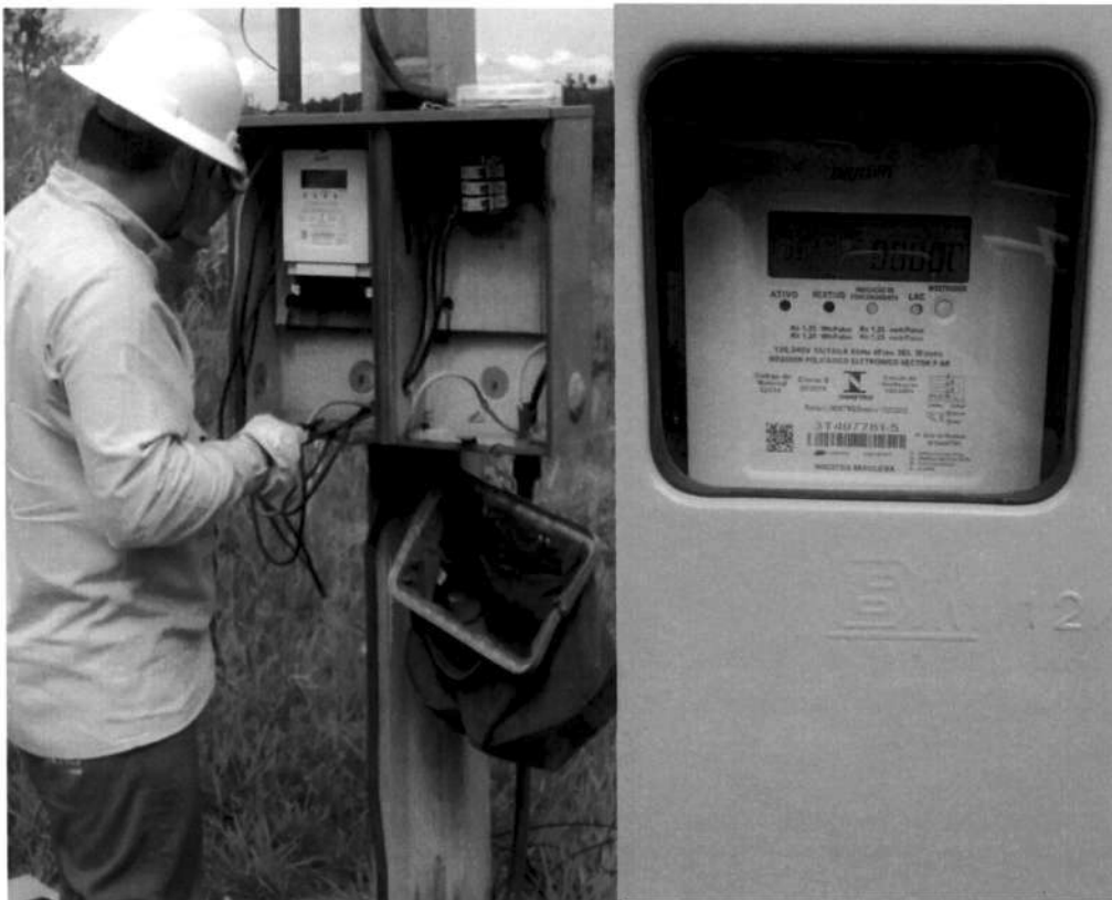
Foto 4 a 5 Instalação Medidor
