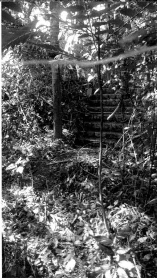
Foto 22 a 23 Manutenção Escada do Castelinho
