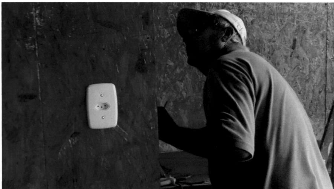
Foto 1 a 3 Instalação Elétrica
