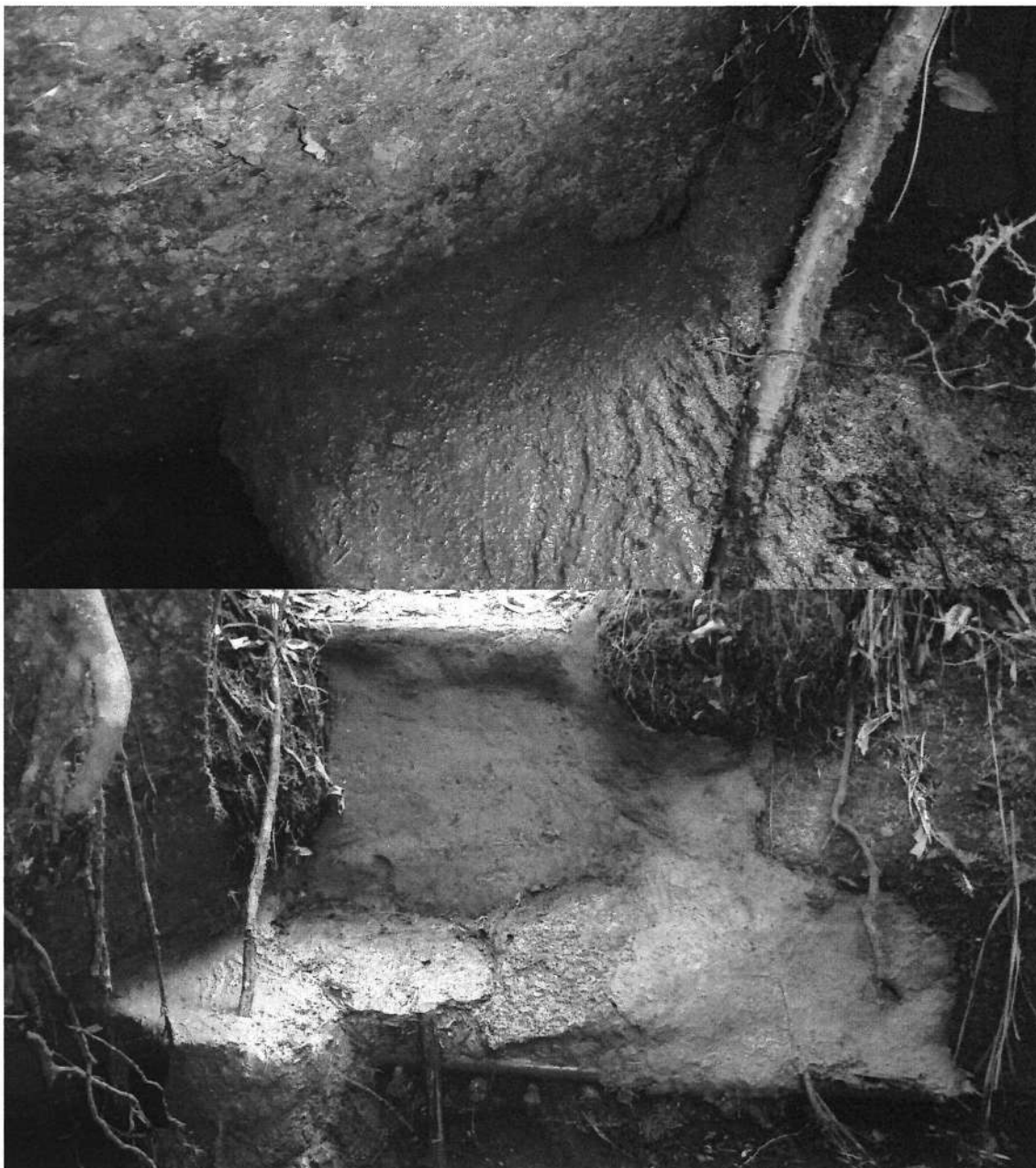
Foto 3 a7 Manutenção barranco do poço
