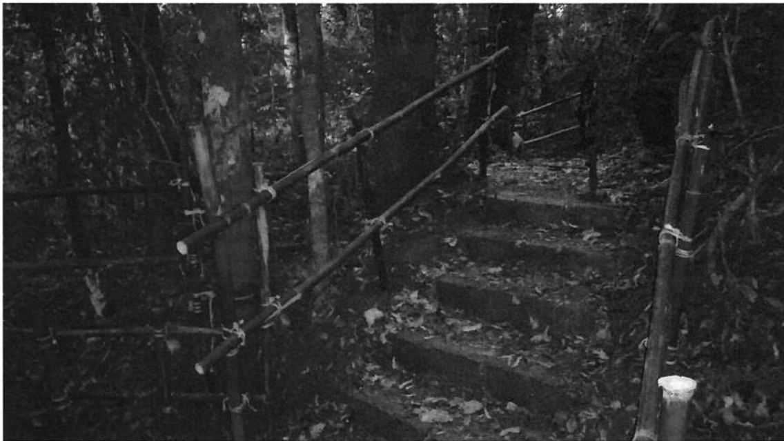
Foto 19 a 21 Reparos nas escada de bambus
