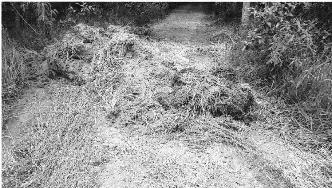
Foto 29 a 319 Acumulo de terra na estrada
