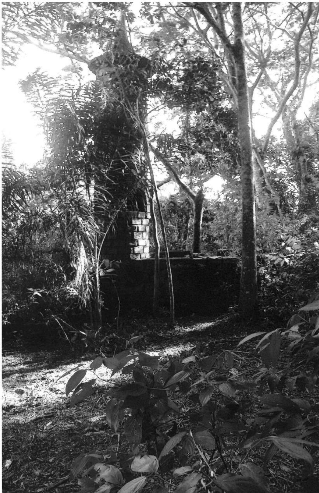
Foto 24 e 25 Manutenção Castelinho
