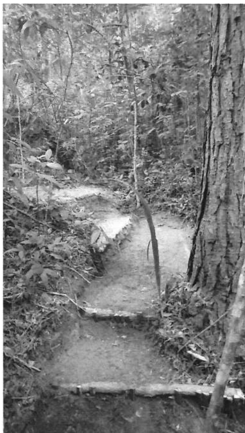
Foto 5 Caixas de Contenção Hidráulicas
