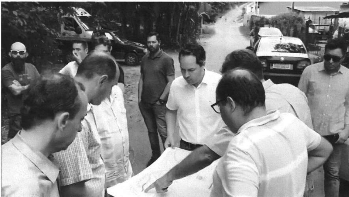
Foto 1 Acompanhamento Obra de Asfalto
