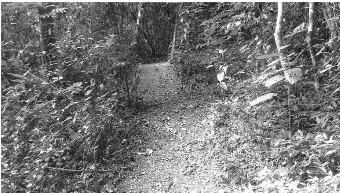
Foto 17 19 Contenção Trilha Dique
