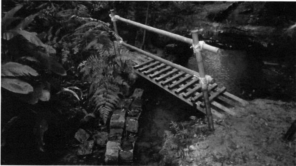
Foto 2 a 3 Queda de Árvore em ponte, limpeza e troca de corrimão
