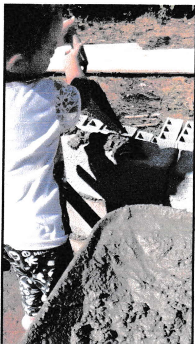
Heloísa ajudando o pai para a construção do quarto dela
