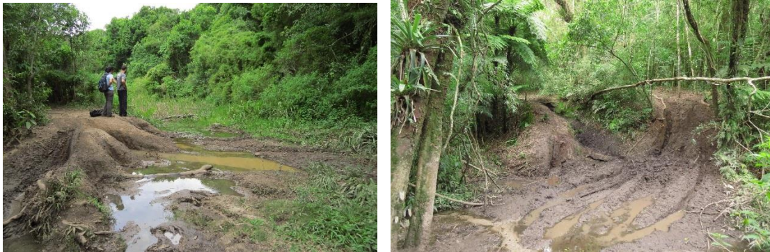
Foto 10 e 11 Danos Causados por Motos de Trilha
