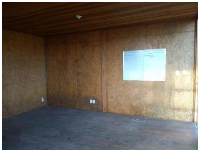
Foto 2 Sala do primeiro andar após limpeza
