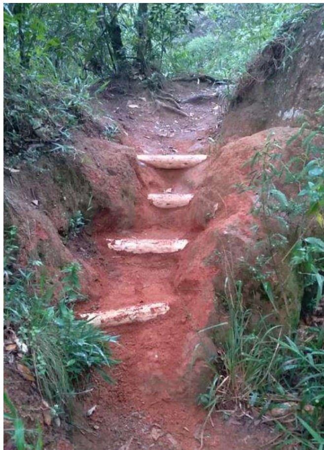
Figura 28 – Implantação de degraus na Trilha da Pedra Rachada.
