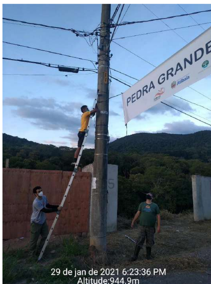
Figura 56 - Instalação de faixa na Estrada dos Pintos, Bairro do Portão
