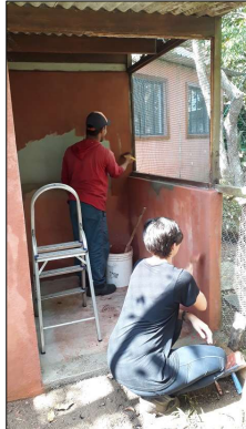
Finalizando a pintura, com envolvimento da estagiária Eduarda
