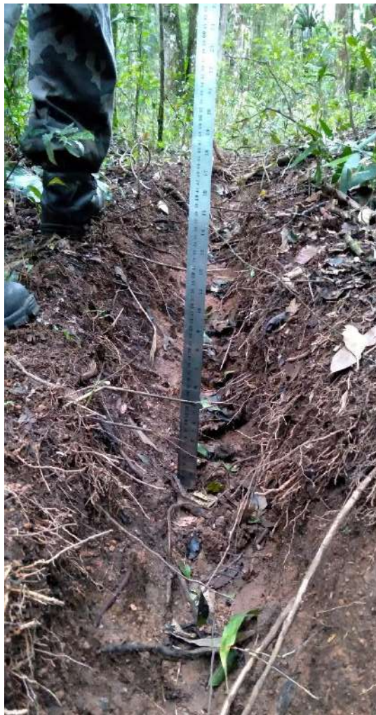
Figura 47 - Erosão causada por motocross em trilha
