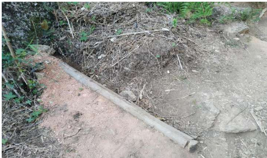
Figura 57 – Corte de água para evitar erosão na trilha da Pedra Rachada
