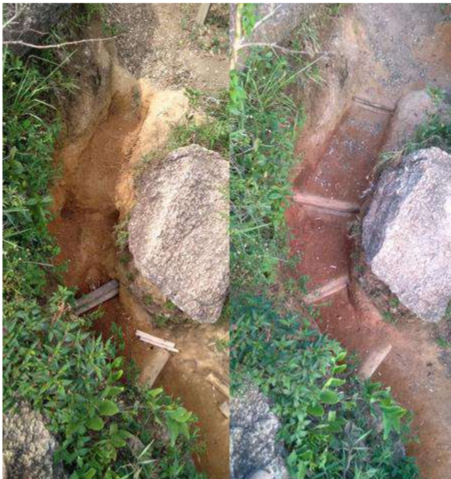
Figura 34 - Exemplo da técnica de instalação de degraus com buracos para encaixe das madeiras
