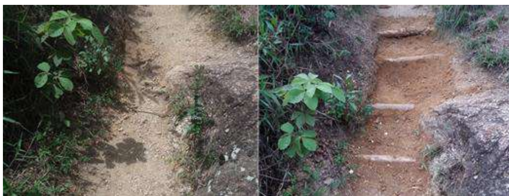
Figura 32 - Antes e depois de instalação de degraus sem escoras na Trilha da Pedra Rachada
