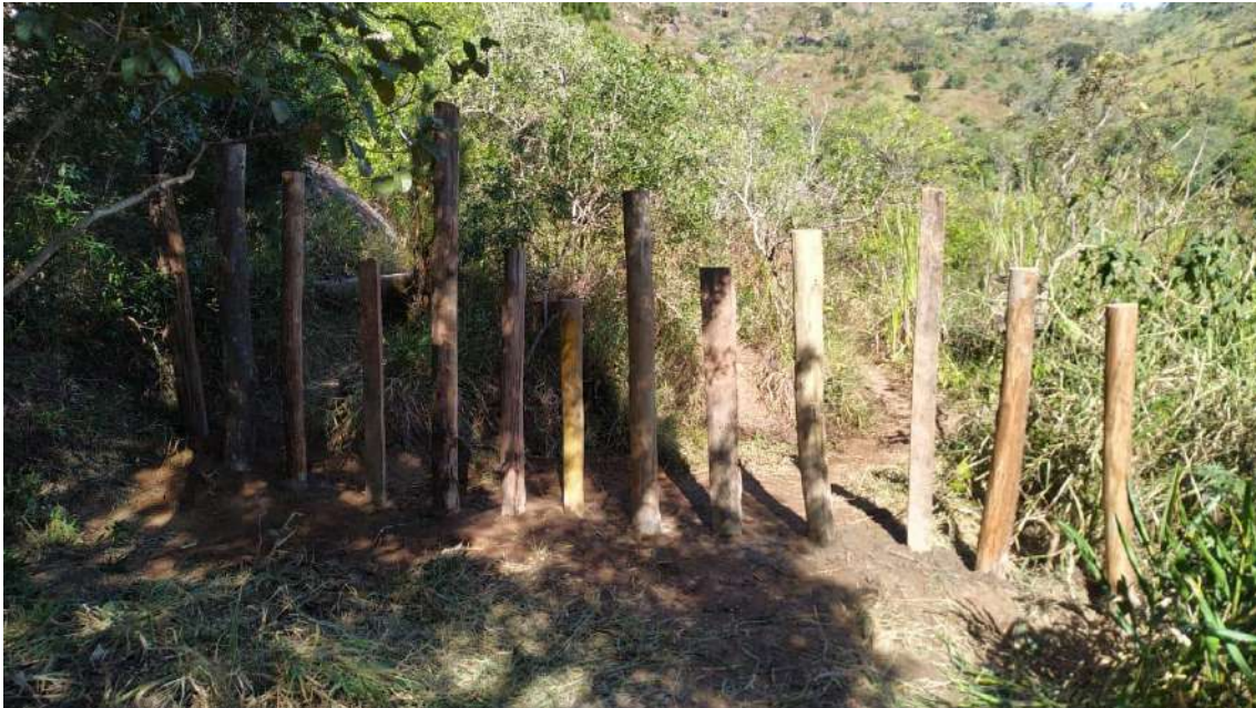
Figura 41 – Processo de implantação de barreira de mourão na trilha de acesso a Gruta São José vindo pelo Arco-Íris
