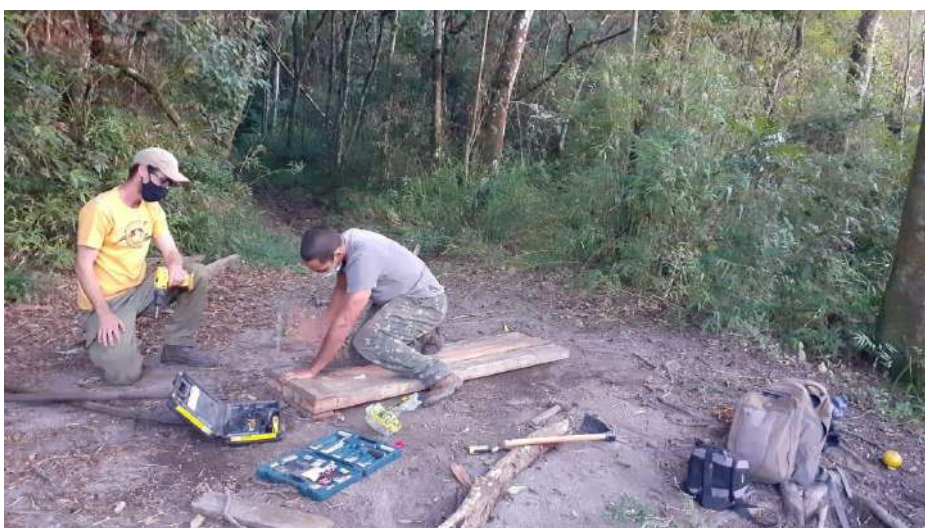
Figura 37 - Construção das pontes de madeiras nas áreas de passagem de água na trilha das Três Marias
