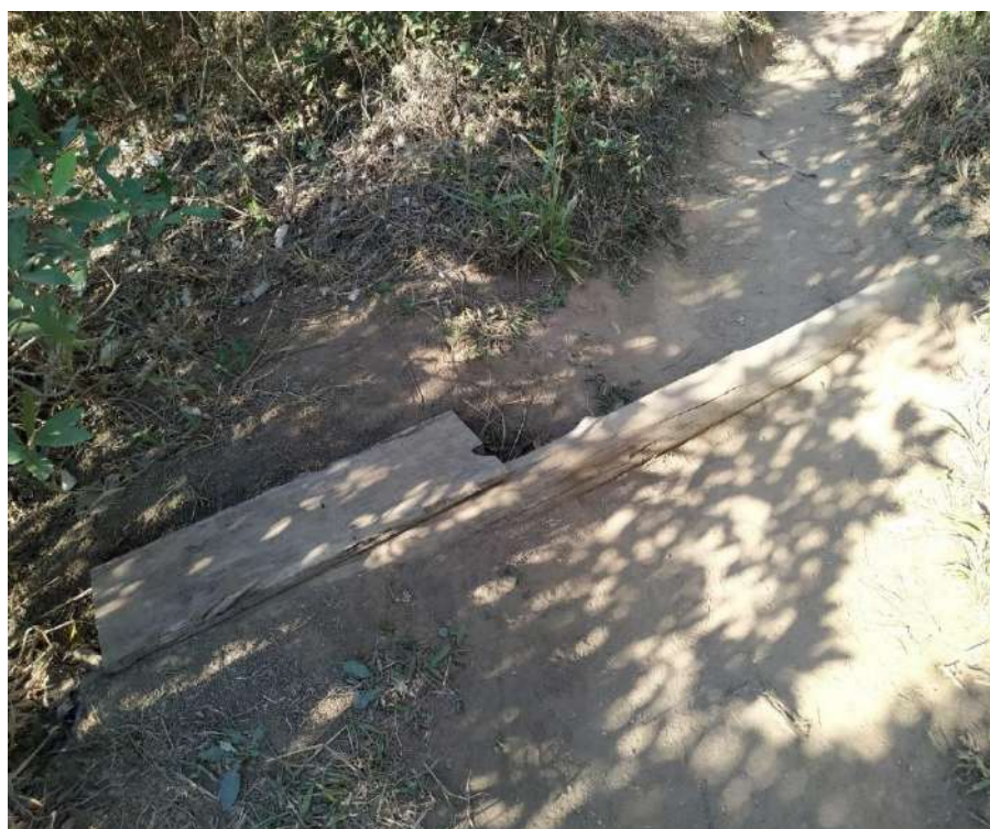
Figura 58 – Exemplo de dispositivo de drenagem
