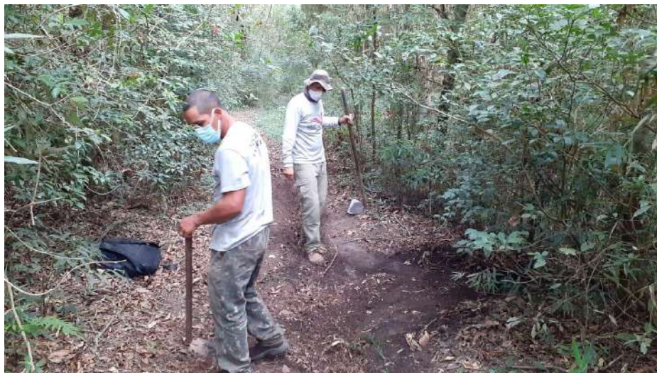
Figura 36 - Trabalho de recuperação da trilha das Três Marias entre as equipes do PNMGF e Pedra Grande
