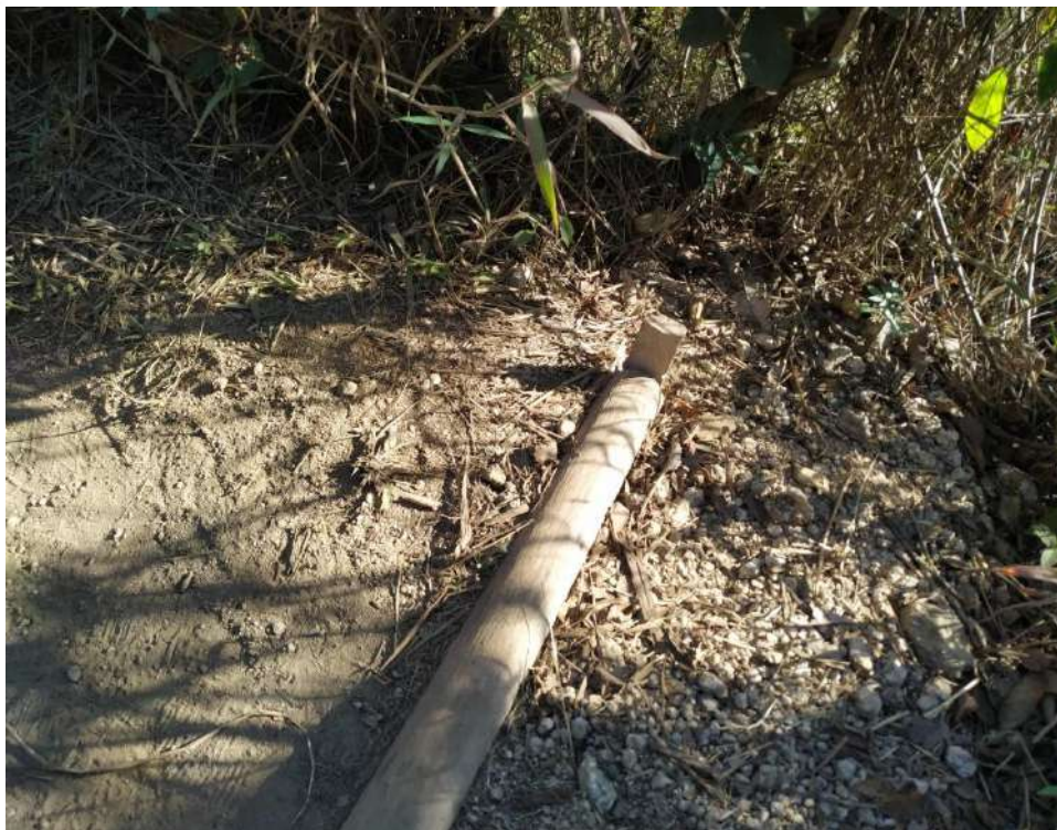
Figura 61 – Degrau instalado para evitar erosão e facilitar o acesso
