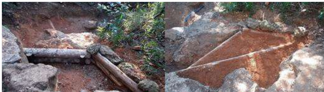
Figura 31 - Instalação de degraus com escora interna na trilha da Pedra Rachada
