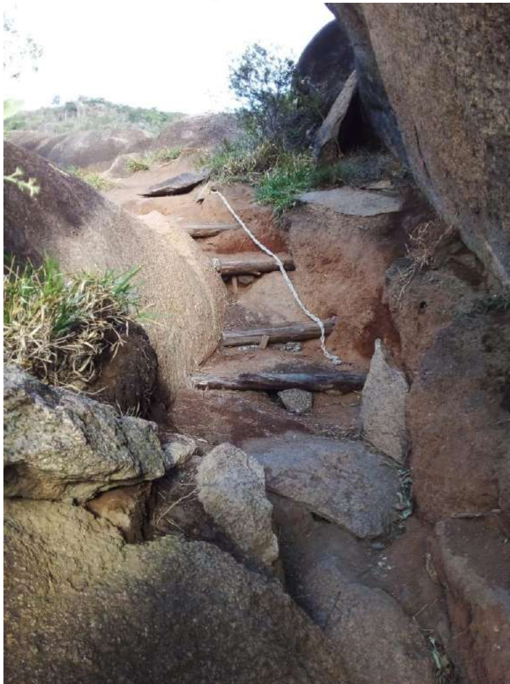
Figura 43 - Degraus fixados em local crítico com corda de apoio para subida
