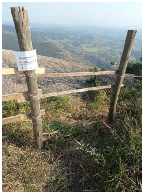
Figura 7 - Barreira localizada na laje sul mais uma vez danificada, mesmo havendo sinalização informativa
