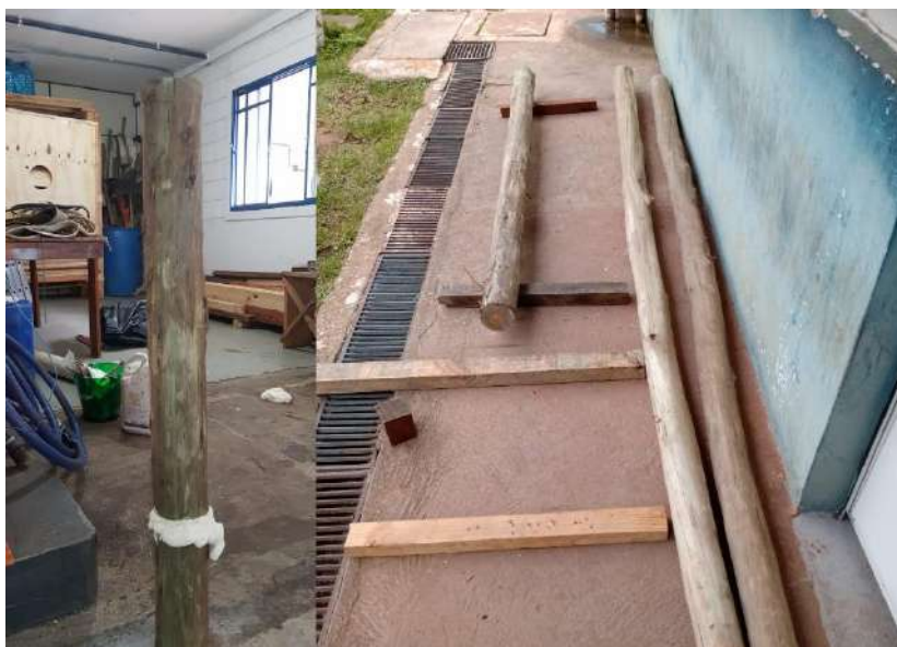
Figura 32 - Poste de 1 metro fixado e madeiras tratadas para confecção dos postes
