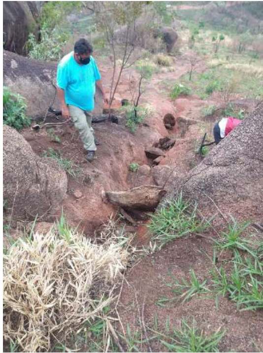
Figura 40 - Escadas hidráulicas de rocha para contenção de erosão severa
