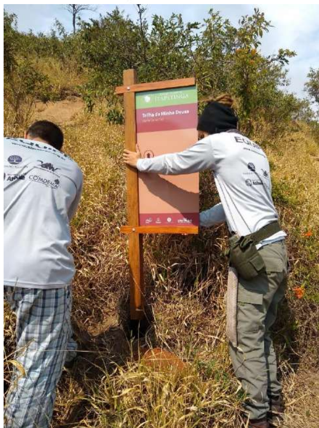
Figura 57 - Fixação das placas indicativas em campo
