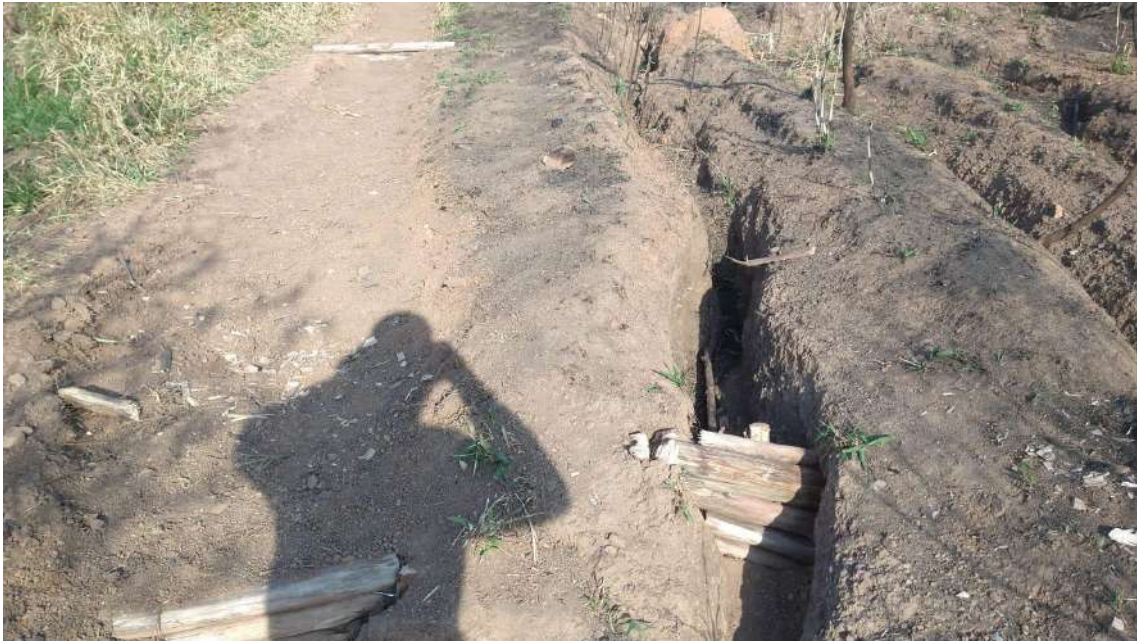
Figura 42 - Escada hidráulica de madeira para contenção de sedimentos
