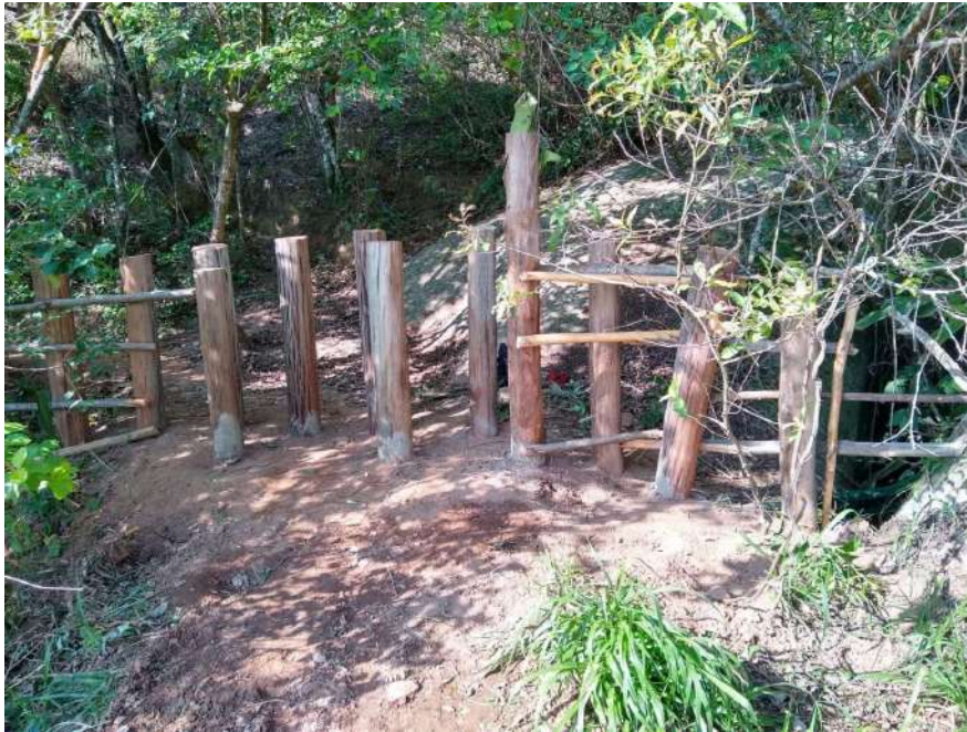
Figura 34 - Fechamento da trilha da mangueira vindo do morro do careca, finalizada
