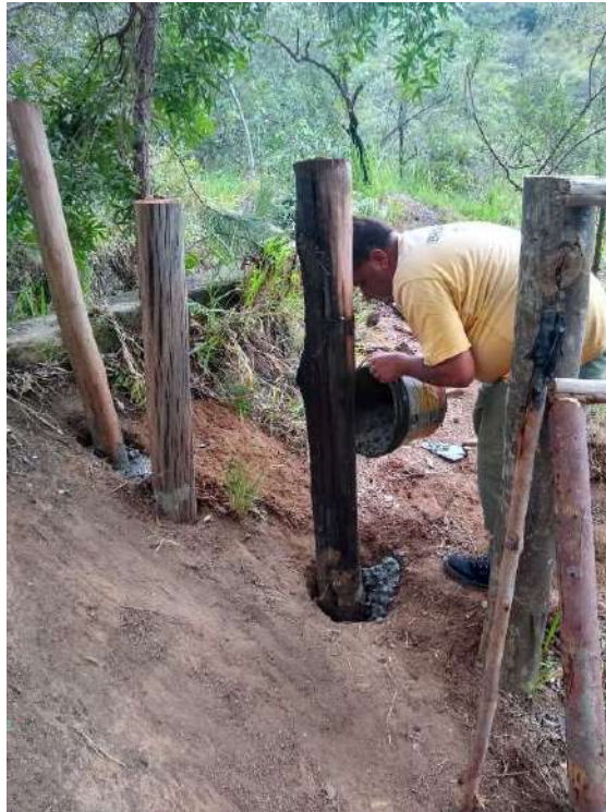
Figura 29 - Barreira de mourão na trilha de acesso a Gruta São José vindo pelo Arco-Íris sendo concertado e reforçado
