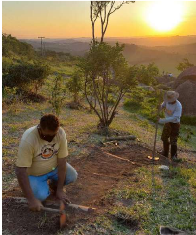
Figura 48 - Manutenção dos acessos e trilhas no Mirante da Pedrinha, realizado pelas equipes dos Termos de Parceria n° 134/2019 e 028/2020 em novembro/2021
