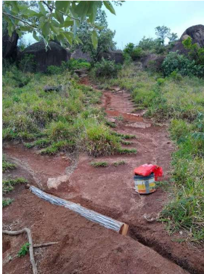
Figura 37 – Saídas de água feitas com madeira no Setor II
