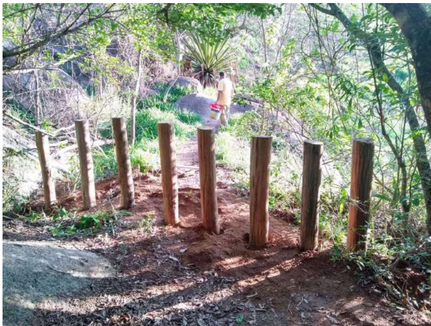
Figura 33 - Mourões instalados e fixados
