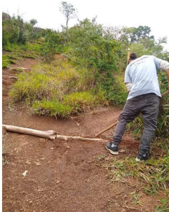
Figura 38 - Voluntario realizando a manutenção na saída de água
