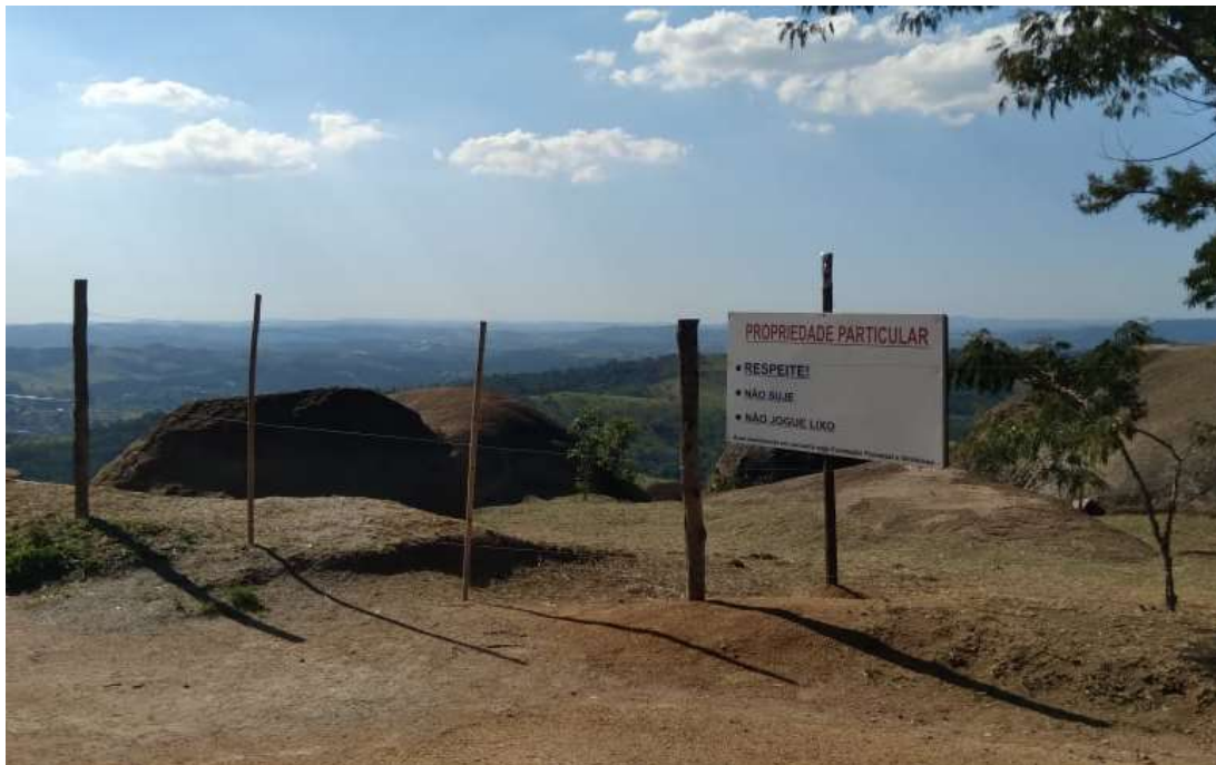
Figura 49 - Instalação de sinalização no Mirante da Pedrinha, realizado pelas equipes dos Termos de Parceria n° 134/2019 e 028/2020 em novembro/2021
