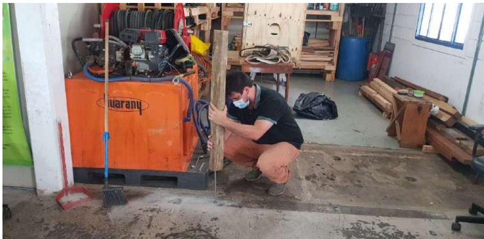
Figura 27 - Fixação do poste de 1 metro na barra roscada e no parabolt
