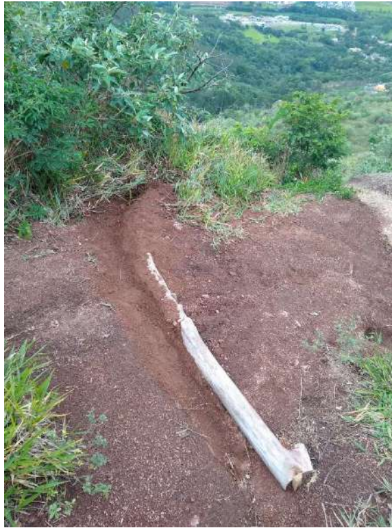
Figura 39 – Saída de água após a manutenção sem nenhum sedimento acumulado
