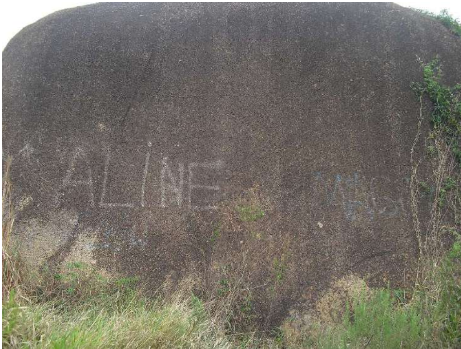
Figura 65 - Operação 5: Pichação em rocha
