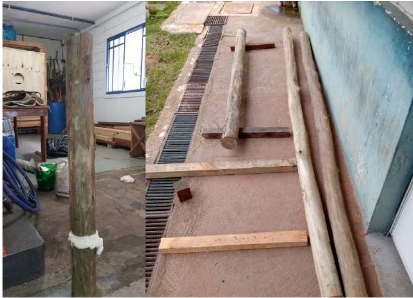
Figura 26 - Poste de 1 metro fixado e madeiras tratadas para confecção dos postes
