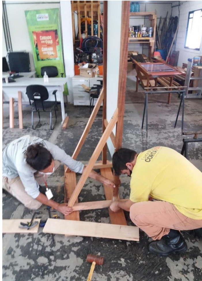
Figura 1 – Montagem da estrutura da placa indicativa
