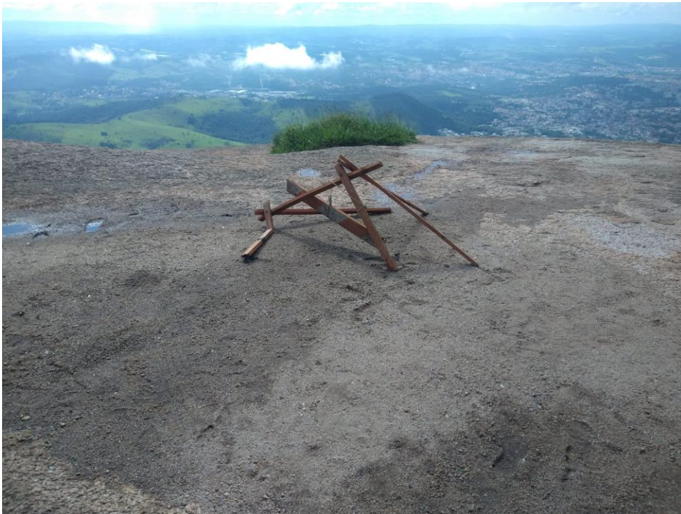
Figura 25 - Cavalete depredado devido a ações antrópicas e naturais
