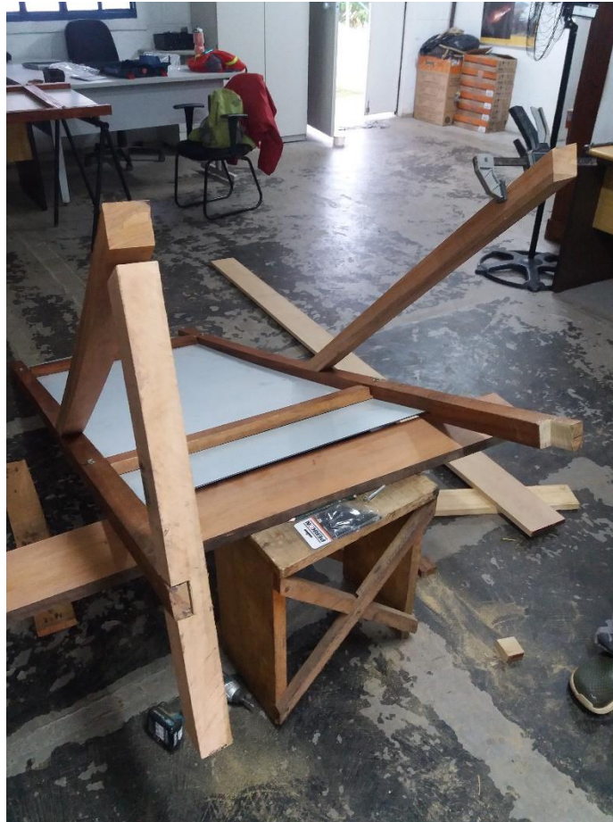
Figura 2 – Montagem da base de sustentação e fixação da placa indicativa.
