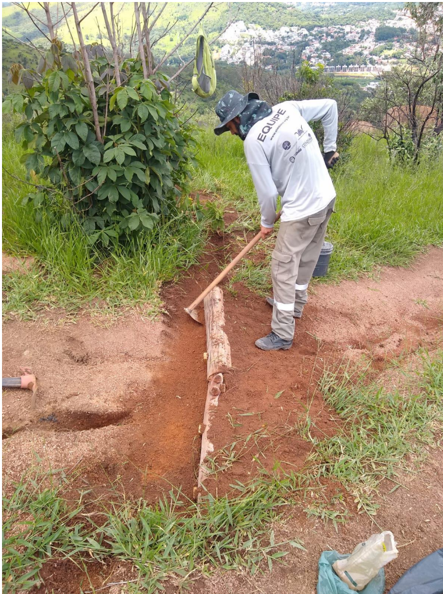
Figura 29 – Abertura do desvio de água – Trilha da Minha Deusa
