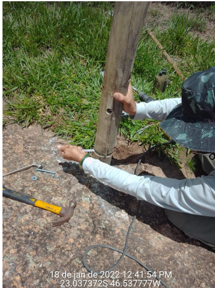
Figura 26 - Fixação do poste de 1 metro na barra roscada e no parabolt
