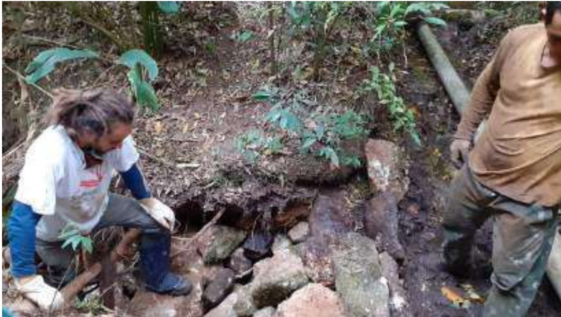
Foto 24: Voluntários e equipe na realização de correção da barragem danificada.
