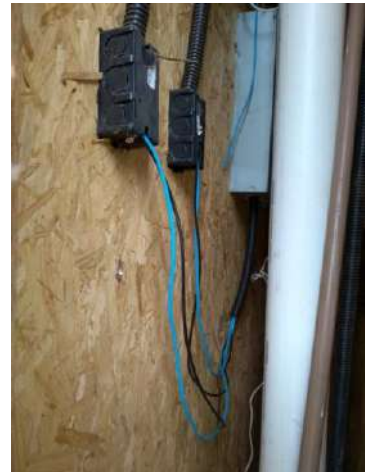
Fotos 8 e 9 Fios descascados e rede elétrica com alto risco de curto circuito e incêndio.
