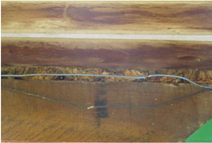
Fotos 8 e 9 Fios descascados e rede elétrica com alto risco de curto circuito e incêndio.
