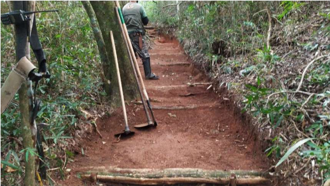
Fotos 54 e 55 Antes e Depois Manutenção Lajeado
