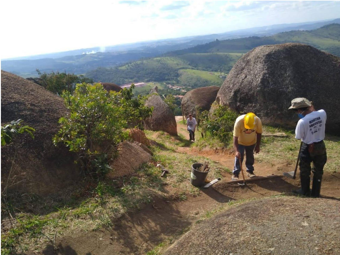
Foto 12 Instalação de Caixa de Contenção Hidráulica
