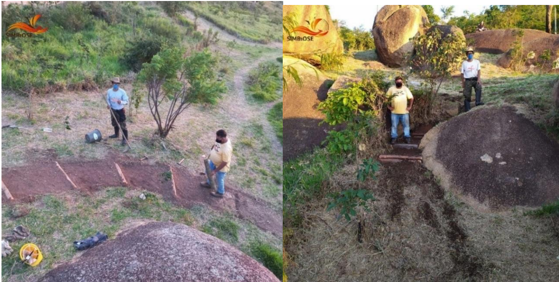
Fotos 17 e 18 Manutenção Pedrinha
