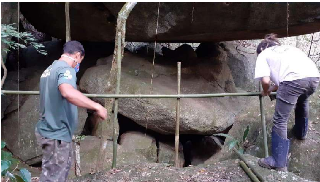
Foto 35 Manutenção Guarda Corpo
