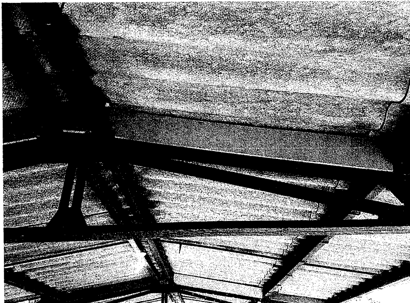
Serviço de vedação da ferragem do telhado do corredor da sala de Educação Física para controle de Pombos
