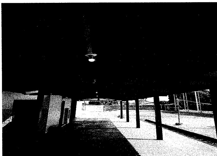
Troca das calhas e lâmpadas por bucais e lâmpadas de led no corredor da Educação Física
