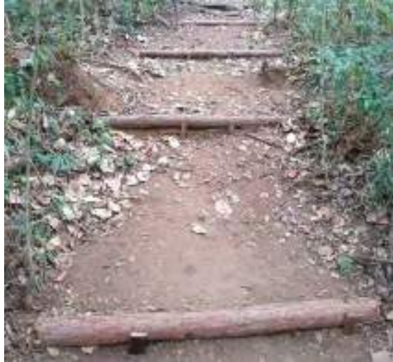
Figura 53 – Degraus de madeira após a manutenção, realizado em agosto de 2022.
