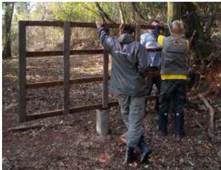
Figura 77 – Instalação da nova porteira limítrofe a propriedade do Sr. Rene Ribeiro, realizada em agosto de 2022.
