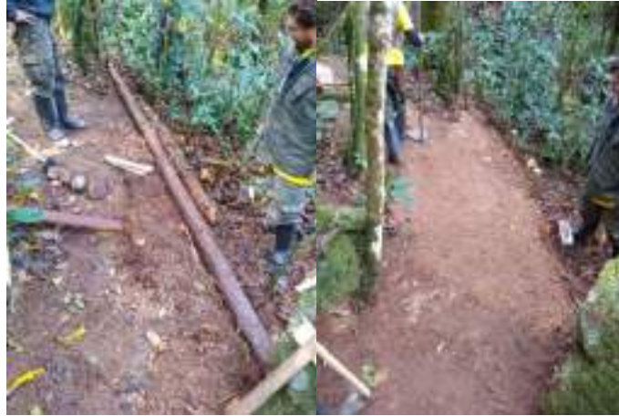
Figura 47 – Trabalho de manutenção e estabilização na Trilha da Gruta do Saci, realizado em agosto de 2022.
