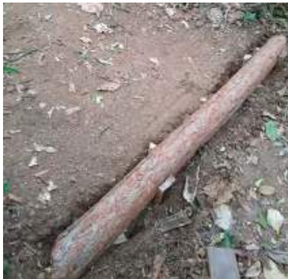
Figura 54 – Novo degrau de madeira instalado e fixado com estacas, realizado em agosto de 2022.
