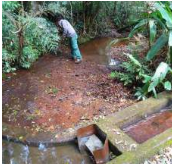
Figura 62 – Margens da Antiga Barragem de Captação de Água durante as manutenções, realizado em setembro de 2022.
