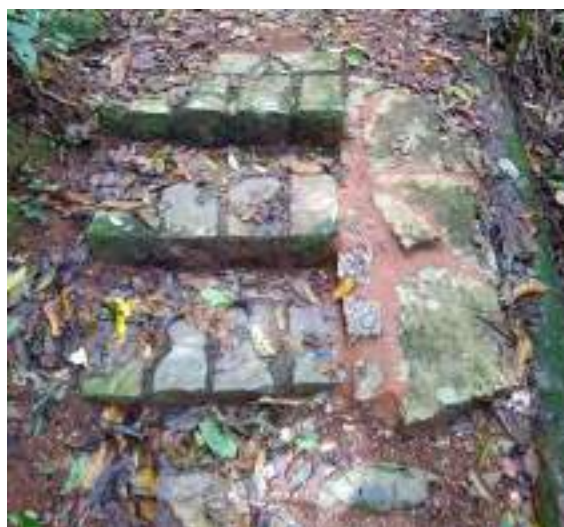
Figura 48 – Trabalho de manutenção no degrau de paralelepípedo, realizado em agosto de 2022.
