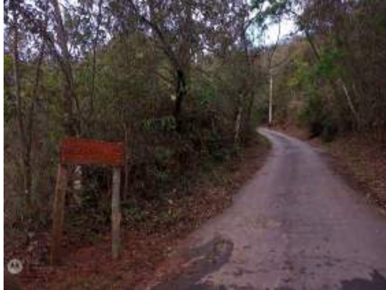
Figura 84 – Placas orientativas instaladas na estrada de acesso ao PNMGF com aviso de “estreitamento de via, buzine ao subir”, realizado em setembro de 2022.
