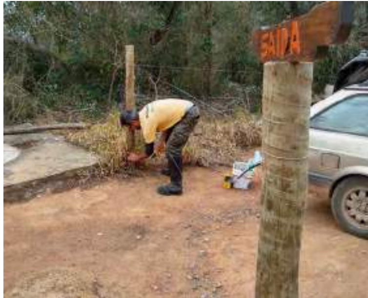
Figura 80 – Reinstalação dos arames no cercamento do Mirante Natural da Pedrinha, realizado em setembro de 2022.
