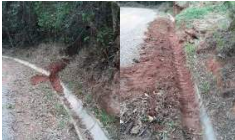
Figura 76 – Limpeza das canaletas de drenagem na estrada de acesso, realizada em setembro de 2022.
