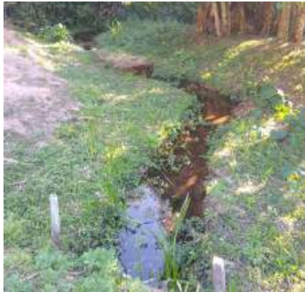
Figura 70 – Local antes da limpeza das margens do córrego, realizado em junho de 2022.
