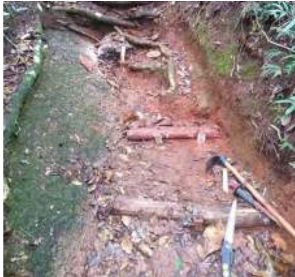
Figura 56 – Local após a instalação de escadas hidráulicas, realizado em agosto de 2022.
