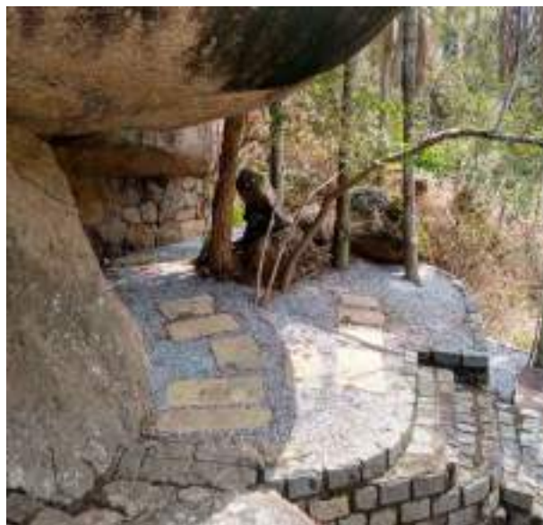
Figura 57 – Mirante do Lago após a remoção dos bancos de pedra, realizado em setembro de 2022.
