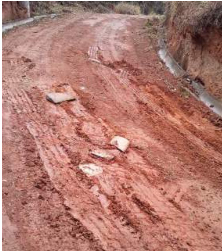
Figura 86 – Trecho da estrada de acesso ao CAVGF com ponto escorregadio, realizado em setembro de 2022.
