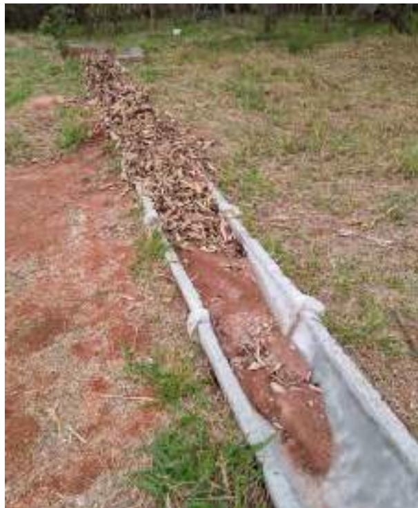
Figura 37 – Processos erosivos acarretados pela falta de compactação da estrada de acesso ao CAVGF.
