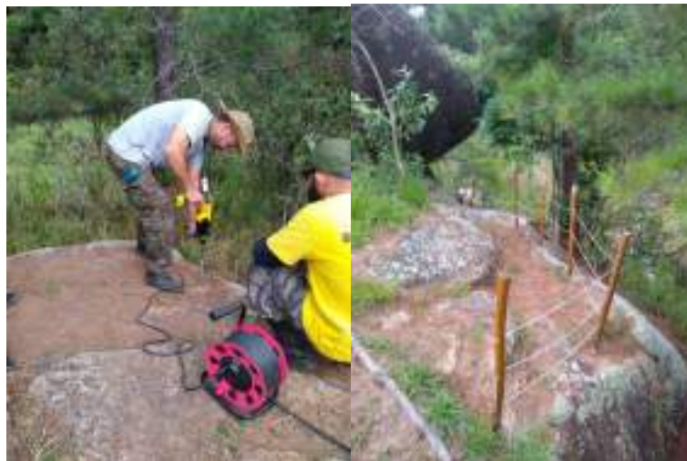
Figura 59 – Instalação do parapeito e manutenção finalizada, realizado em novembro de 2022.
