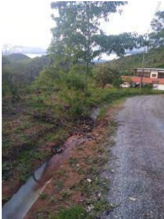
Figura 37 – Sedimentação nas canaletas de drenagem da estrada de acesso ao CAVGF, realizada em janeiro de 2023.
