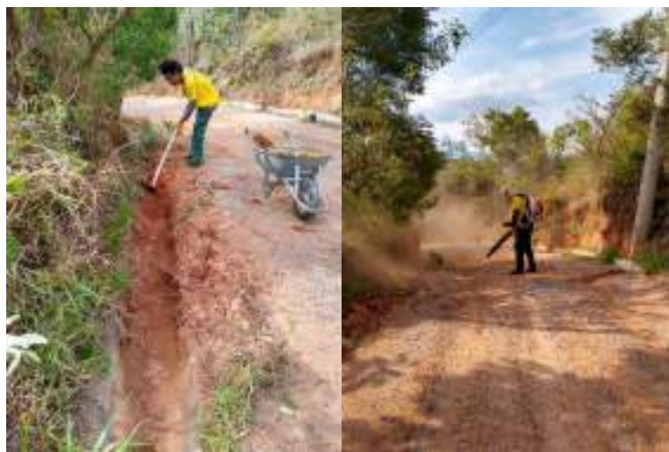
Figura 76 – Manutenção de canaletas e retirada de acúmulo de brita na estrada de acesso ao CAVGF, realizado em janeiro de 2023.
