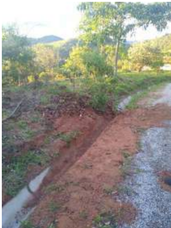
Figura 38 – Desobstrução das canaletas de drenagem da estrada interna de acesso ao CAVGF, realizada em janeiro de 2023.
