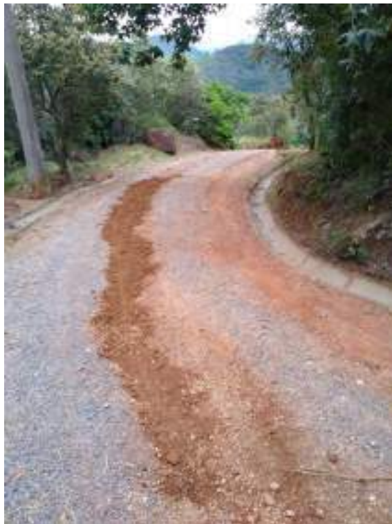
Figura 40 – Manutenção na estrada interna de acesso ao CAVGF, realizada em janeiro de 2023.
