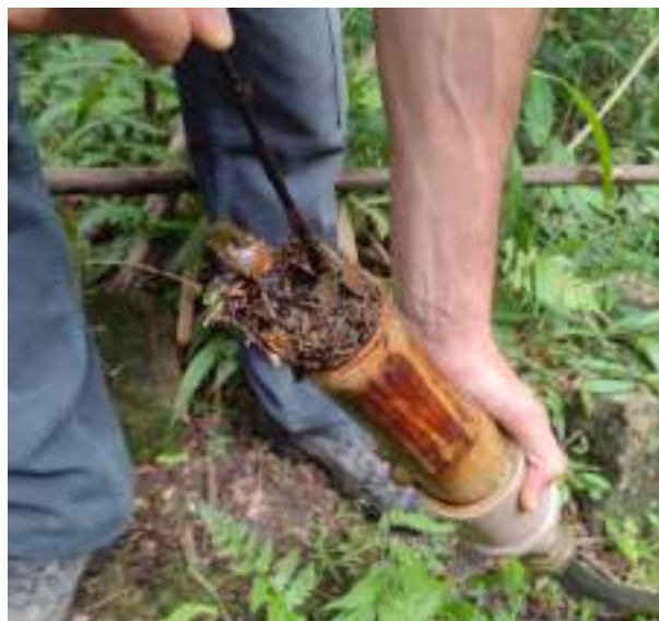
Figura 70 – Limpeza do sistema de captação que abastece o CAVGF, realizado em janeiro de 2023.
