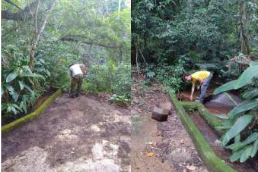
Figura 71 – Manutenção no sistema de barramento da Antiga Captação, realizado em janeiro de 2023.
