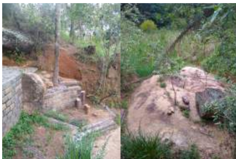
Figura 60 – Manutenções no Mirante do Lago, realizado em novembro de 2022.
