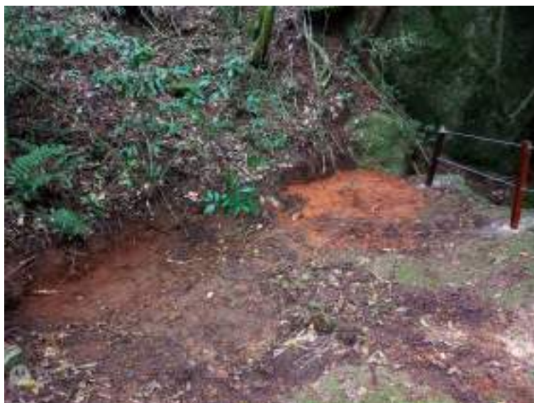
Figura 56 – Contenção e estabilização na Gruta do Saci após o manejo, realizado em janeiro de 2023.
