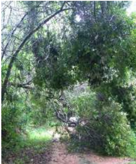
Figura 77 – Avaliação da área de queda de árvore na estrada de acesso à Capela, dezembro de 2022.
