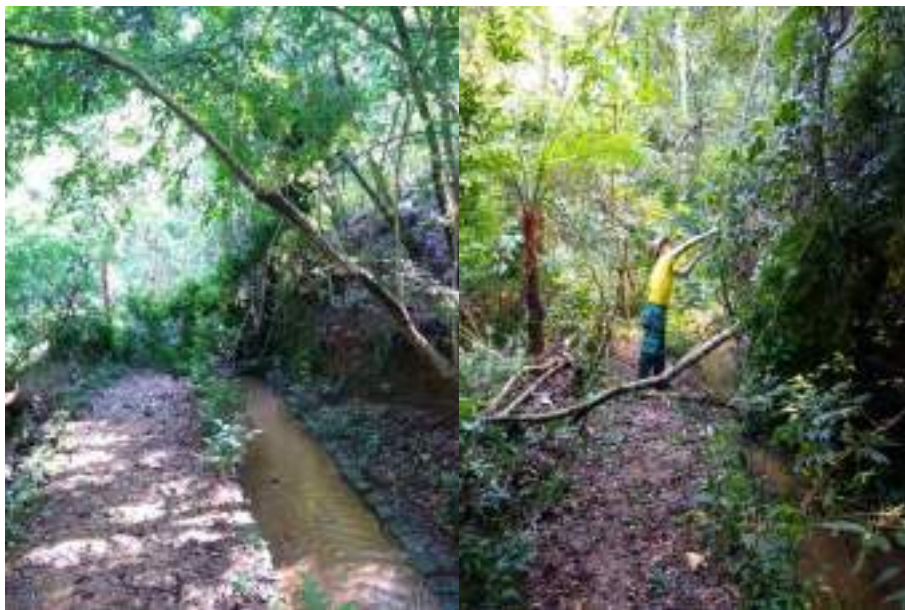
Figura 61 – Manutenções na Trilha do Milho Vermelho para remoção de árvore caída, realizado em janeiro de 2023.
