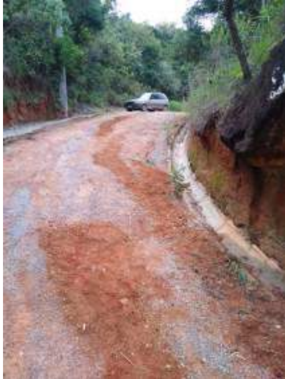
Figura 39 – Manutenção na estrada interna de acesso ao CAVGF, realizada em janeiro de 2023.
