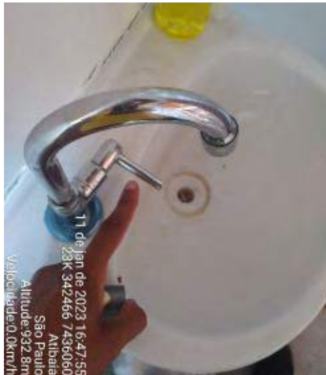
Figura 24 – Ponto hidráulico da pia do banheiro da Sede Ambiental sem água.
