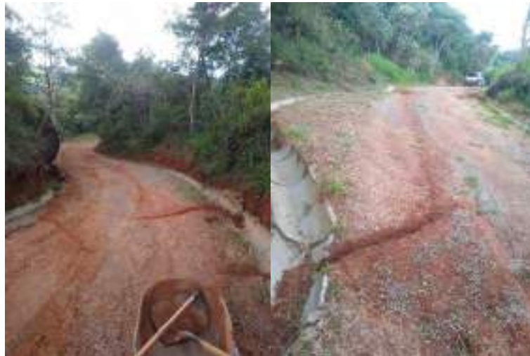
Figura 5 –Canaletas de drenagem para melhoria do escoamento superficial, realizado em fevereiro de 2023.
