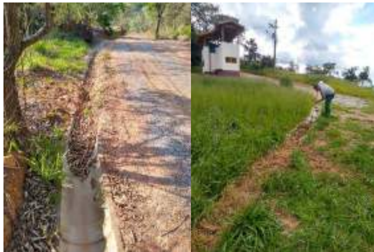
Figura 6 – Manutenção nas sarjetas de drenagem da estrada de acesso, realizado em fevereiro de 2023.
