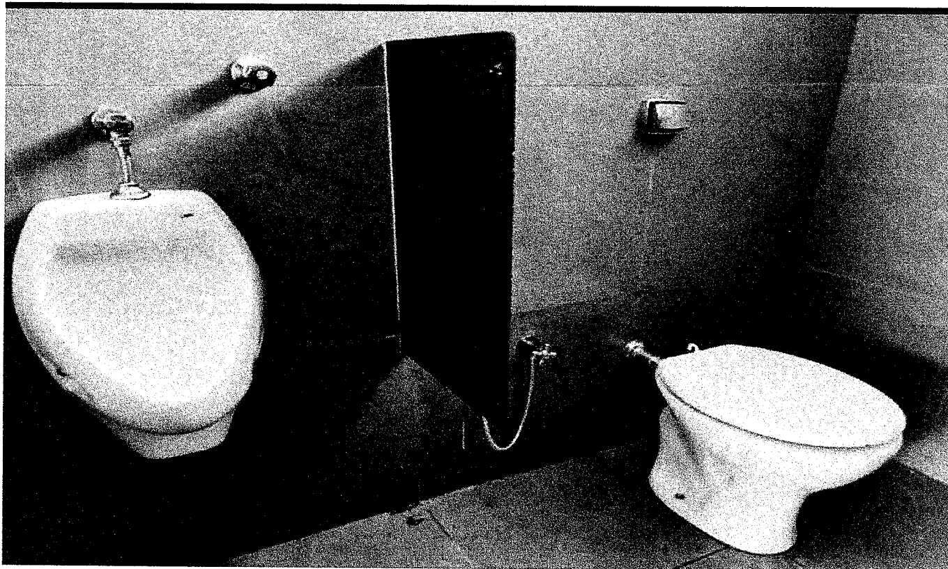
REFORMA BANHEIRO DOS FUNCIONÁRIOS – META 4
