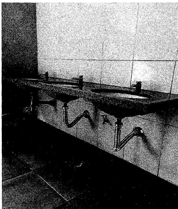
Manutenção dos banheiros (troca de sifões, instalação de capas de válvulas hydras, etc.
