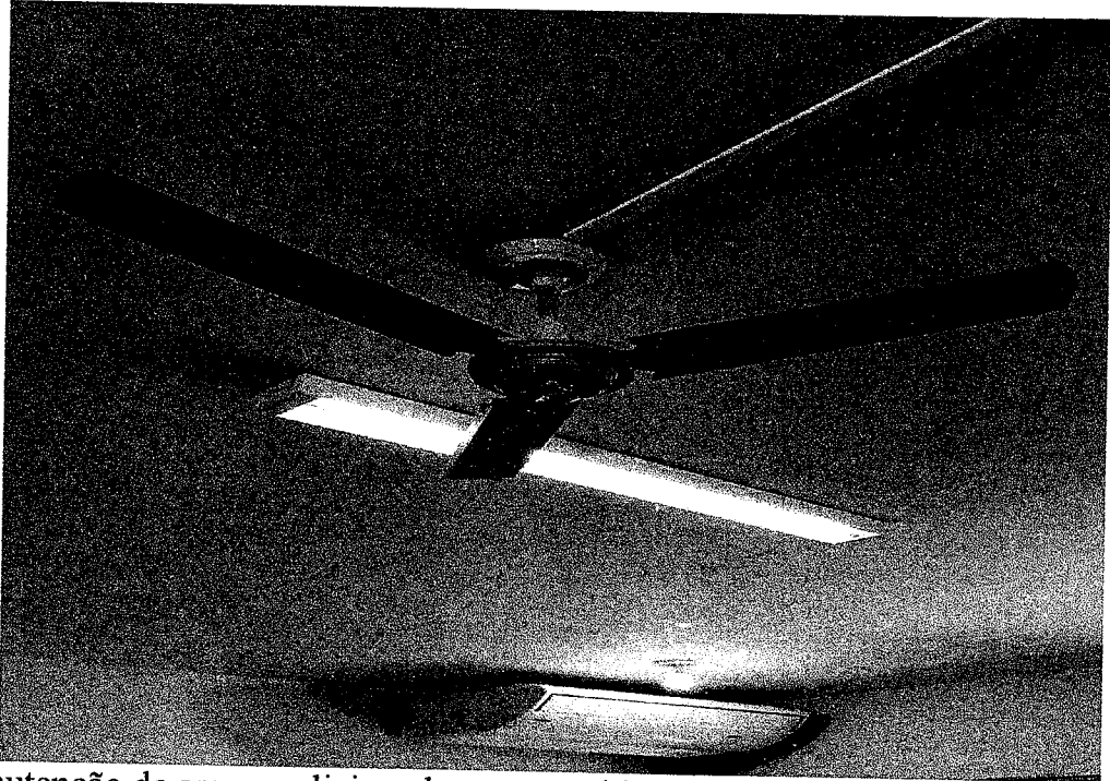
Manutenção de ares condicionados com problemas e instalação de 5 ventiladores
