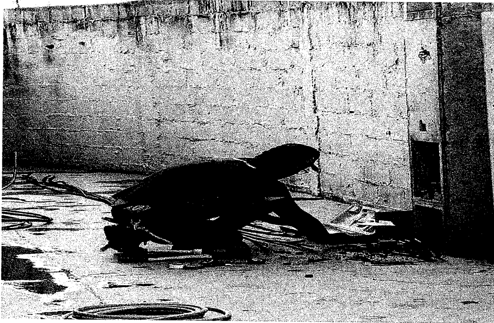
Serviços na rede elétrica
