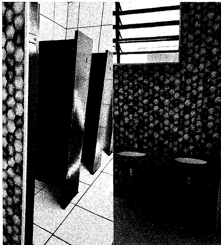
Figura 22 - banheiro masculino reformado
