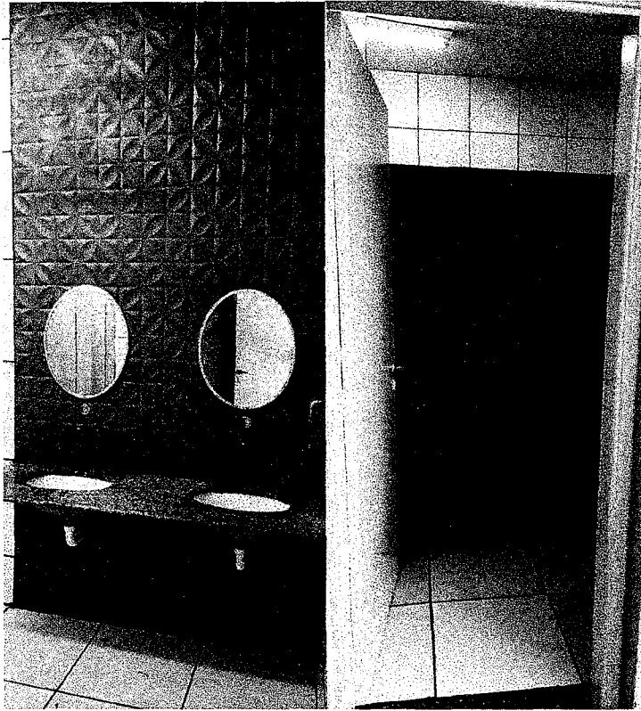
Figura 21 - banheiro feminino reformado
