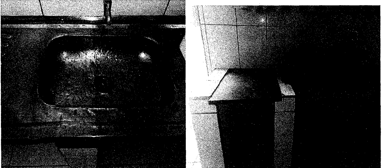
Figura 23 - cozinha antes da reforma
