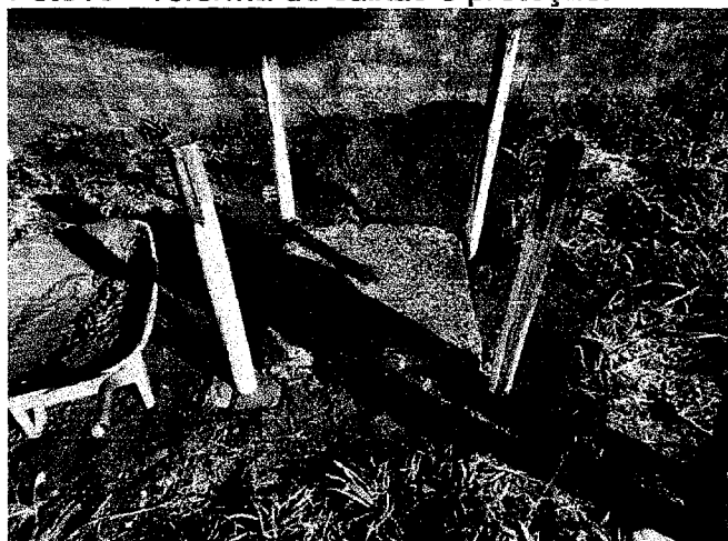
Foto 17 – reforma caixas pluviais.
