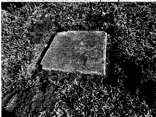
Foto16 – reforma de caixas e proteção.
