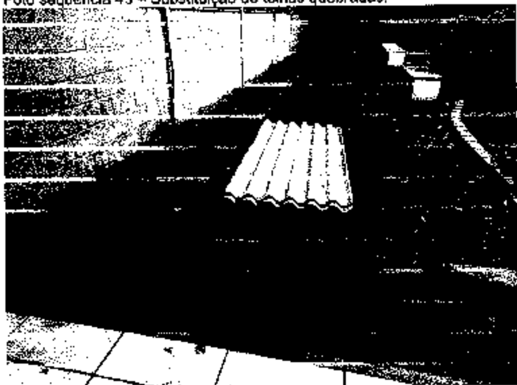
Foto sequência 43 – Substituição de telhas quebradas.
