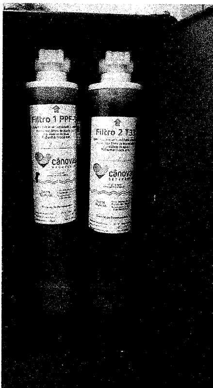
Figura 2 Troca de filtros de bebedouros em Cemepe
