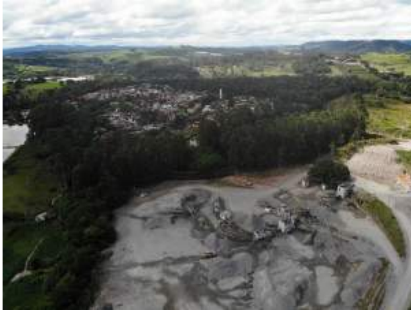
Imagens 52 – Imagem aérea da restauração em APP na Pedreira Atibaia
