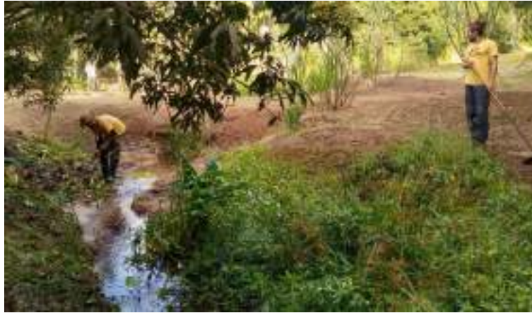
Figura 68 – Área do setor III à jusante do Córrego do Milho Vermelho durante as ações de manutenção.
