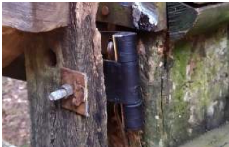
Figura 82 – Dobradiça que foi necessária limpar e lubrificar na porteira de acesso à Capela de Santo Antônio em maio de 2022.
