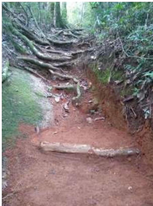
Figura 67 – Degrau restaurado após a manutenção realizada.
