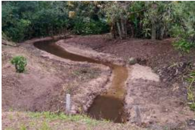
Figura 69 – Área do setor III à jusante do Córrego do Milho Vermelho após as ações de manutenção.
