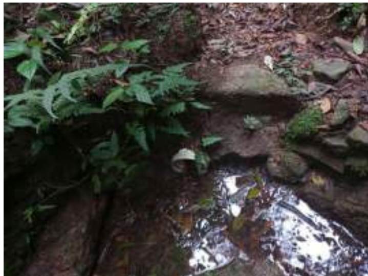
Figura 33 – Barragem de captação encontrada no local.
