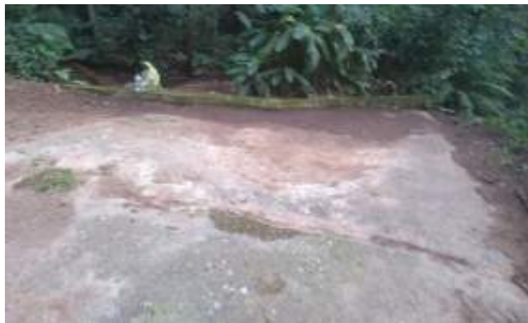
Figura 64 – Área de observação da antiga captação após a manutenção realizada.
