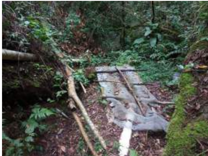
Figura 32 – Vista do decantador de sedimentos instalado a jusante da barragem.
