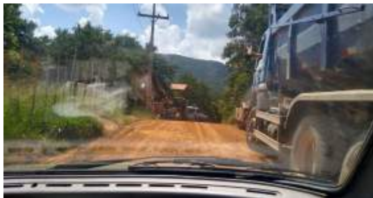
Figura 38 – Manutenção na estrada de acesso ao CAVGF, realizada em 08/03/2022.
