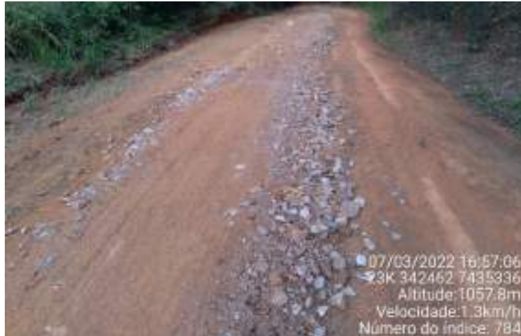
Figura 39 – Registro dos resíduos de construção civil utilizados na manutenção da estrada de acesso ao CAVGF.
