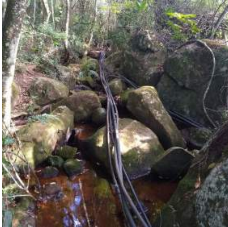
Figura 30 – Mangueiras utilizadas para a captação de água do Córrego do Guará.
