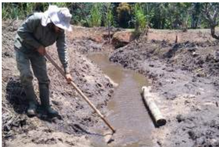
Figura 70 – Área do setor II do Córrego do Milho Vermelho durante as ações de manutenção.
