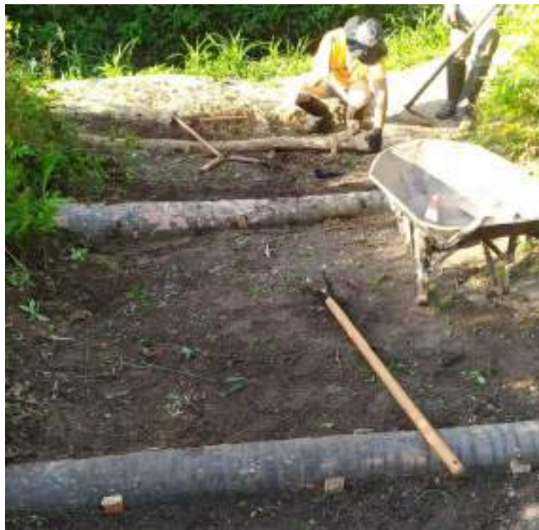
Figura 37 – Instalação de escada hidráulica para diminuir os efeitos do escoamento superficial e o avanço de processos erosivos.
