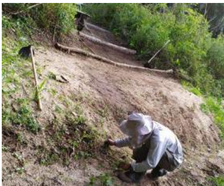
Figura 72 – Setor I do Córrego do Milho Vermelho com contenção de processos erosivos instalados.
