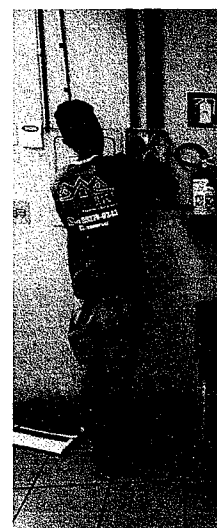
Troca de fiações do pátio e montagem de quadro de distribuição e troca dos cabos do pavilhão de baixo
