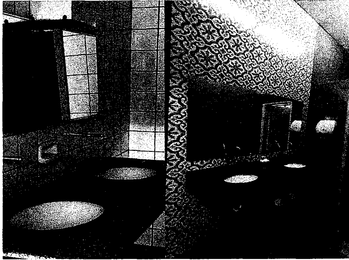
Figura 19 - banheiros antes da reforma Figura 17 - banheiros depois da reforma
