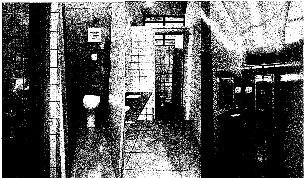
Figura 220 - banheiro feminino antes e depois de reformado
