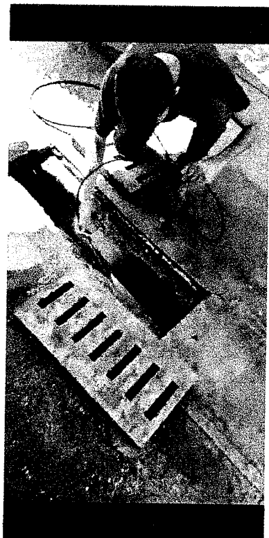
Figura 8 Limpeza de canaleta de águas pluviais
